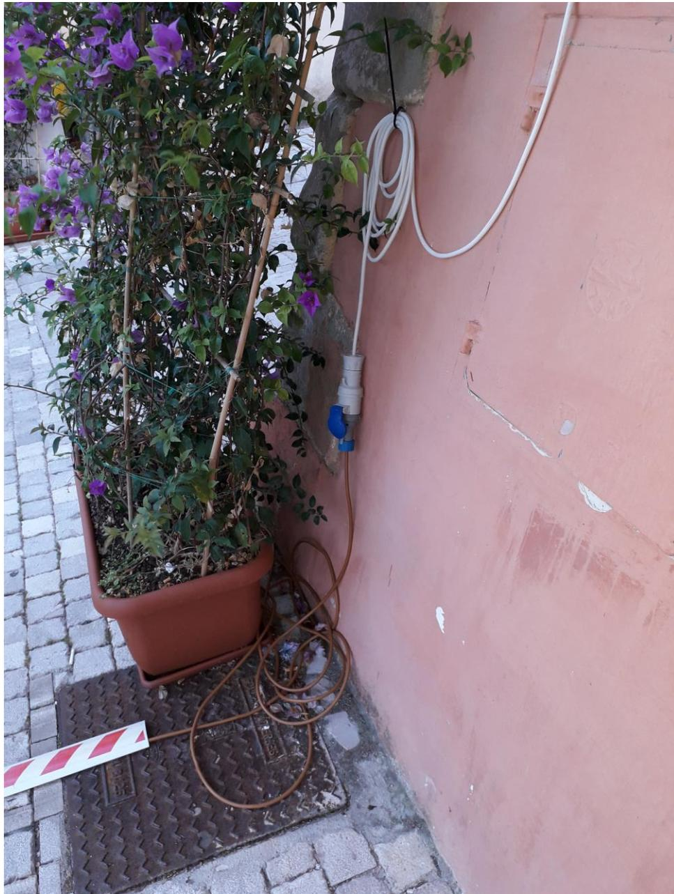
Foto 1 Piazza Vittorio Veneto – raccordo alimentazione pedana con cavo volante diretto a quadro di distribuzione
